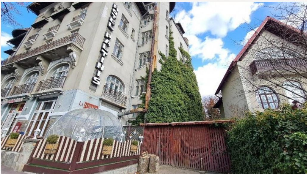
Exemplu de perete viu dezvoltat pe fațada Hotelului Păltiniș din Sinaia
