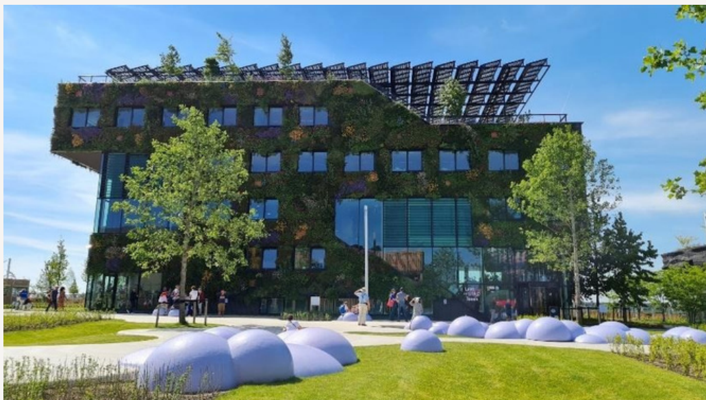
Clădirea Universității din Almere din Olanda dotată cu pereți verzi realizați cu structuri specializate (vedere de ansamblu)
