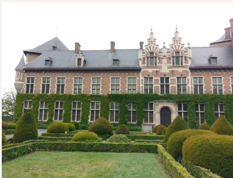
Exemplu de perete viu realizat pe fațada Castelului Gaasbeek din Belgia
